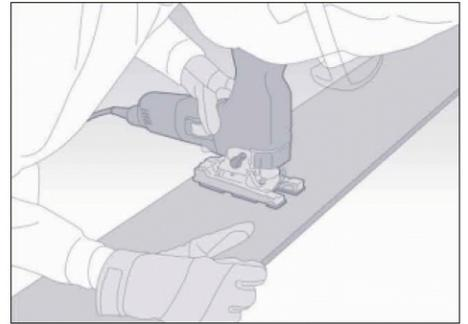
После установки последней доски под окном приложите отлив (не монтируя его) и отметьте расположение отлива на доске. Переверните доску и начертите контур подоконника на задней части доски. Оставьте зазор 10 мм между отливом и доской для вентиляции.
