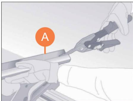
Обрежьте профиль внешнего угла по высоте окна (до отлива).
