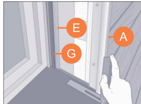
Обрежьте соединительный профиль по высоте окна. С внутренней стороны приклейте полоску уплотнительной ленты к соединительному профилю и проведите полоской пенополиуретанового клея по боковой стороне профиля. Приклейте профиль к оконной раме, следя за тем, чтобы он выровнялся с угловым профилем и не мешал открытию окон.
