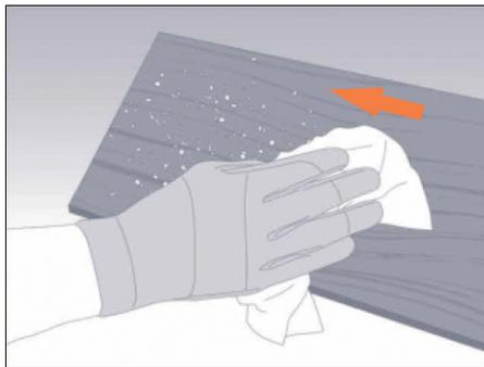
После резки удалите пыль при помощи сухой тряпки из микрофибры и **НЕ ДОПУСКАЙТЕ ПОПАДАНИЯ ВЛАГИ НА ЦЕМЕНТНУЮ ПЫЛЬ!**
