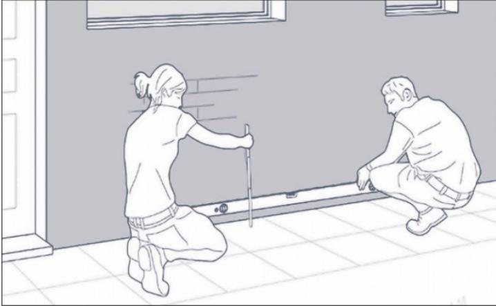
Перед установкой брусков отмерьте 15 см от наивысшей точки фундамента и отметьте полученную точку на стене, затем нарисуйте мелом линию по периметру фасада, проверяя ее строительным уровнем.
