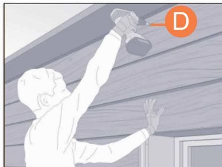
Прикрепите доску наверху с помощью гвоздей или саморезов и подкрасьте их. Или используйте саморезы с окрашенными шляпками в цвет материала.
