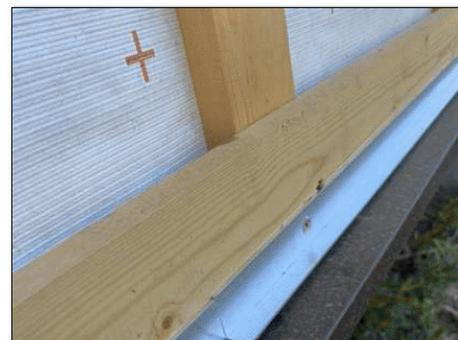
Вертикально установите стартовый профиль (А). Горизонтально установите стартовый профиль для вертикального монтажа.
