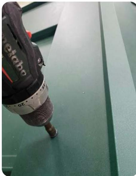
Закрепите конек к планке вентпрогона опорного кровельными саморезами.
