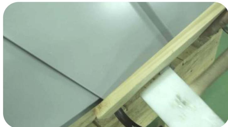
Подготовленную панель Кликфальца®PRO установите на скат, защелкните замок.
