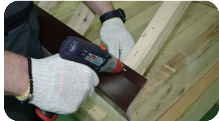
Перед монтажом планки капельника удалите защитную пленку. Смонтируйте планку капельника вдоль края стропил, используя оцинкованные гвозди или саморезы с прессшайбой.
