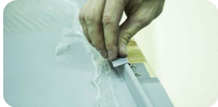
Закрепите подготовленную панель саморезами с пресшайбой, а также самодельными кляммерами по линии торца.
