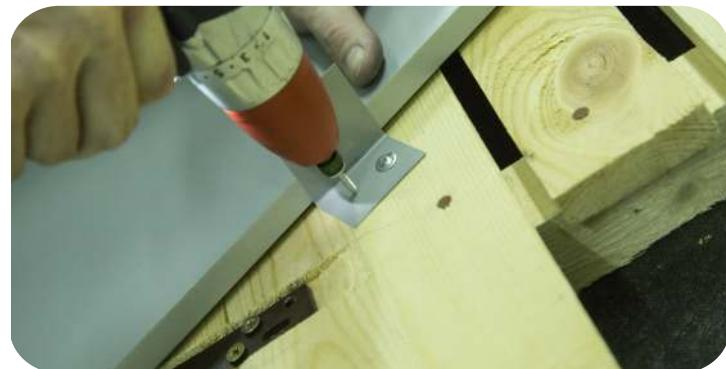
Закрепите ендову на самодельные кляммеры с шагом 400-500 мм. Планка ендовы укладывается от карниза к коньку с нахлестом 300 мм.
