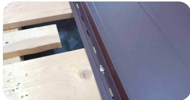
Вкручивайте саморезы строго под углом 90° к обрешетке, избегайте перетягивания саморезов. Перетянутые саморезы будут препятствовать тепловому расширению панелей, а саморез, закрученный под углом, может помешать креплению следующей панели. Эти нарушения могут привести к появлению деформаций.
