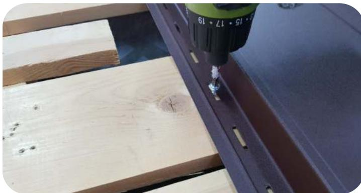
Панели крепятся саморезами с прессшайбой в центр отверстия гвоздевой полки.
