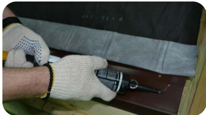
На капельнике закрепите материал при помощи двустороннего скотча или клея-герметика.
