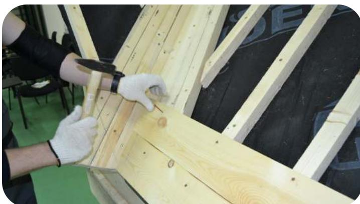
Для монтажа обрешетки используйте доски толщиной 25 мм с влажностью не более 20%, (при межстропильном расстоянии <700 мм допускается толщина 20 мм ).
