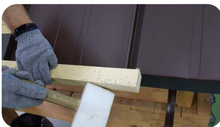
Подготовленную панель установите на скат, защелкните замок. Используя брускок и киянку, выровняйте панель относительно первой.
