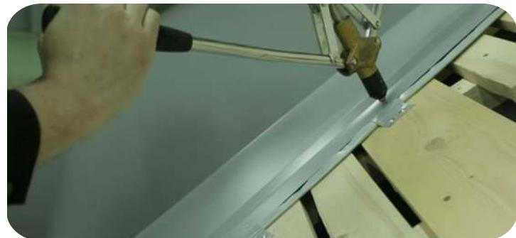
Зафиксируйте крепежную планку с помощью вытяжных заклепок по обеим сторонам вдоль линии ендовы, не ближе чем 150 мм к центру ендовы.
