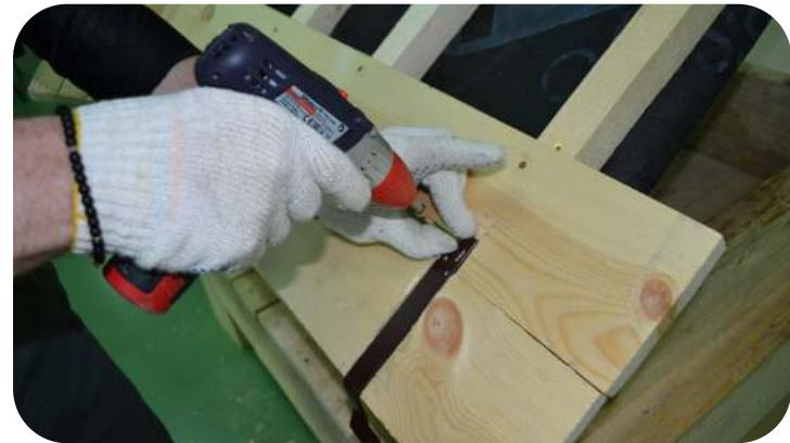
Закрепите подготовленные крюки водосточной системы в пазах оцинкованными саморезами с шагом, рекомендованным производителем. Ни крюки, ни саморезы не должны выступать выше обрешетки.
