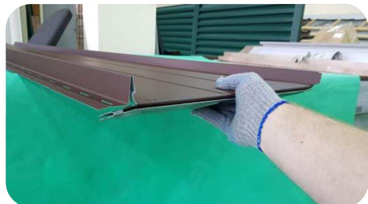
Инструментом для подгиба карнизного свеса сделайте загиб выступающего края панели на 15-30°
