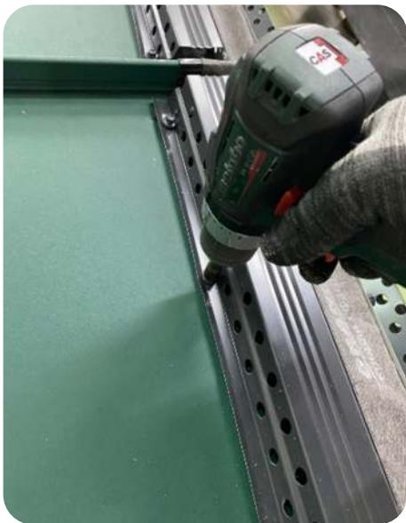
Закрепите планку вентпрогона опорного кровельными саморезами.
