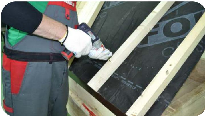
Поверх гидроизоляционного материала на стропила смонтируйте контробрус.
