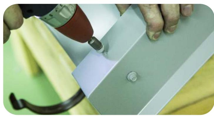
Уложите торцевую планку на брусков и закрепите кровельными саморезами в верхнюю и торцевую часть с шагом 500 мм. Сделайте загиб на краю торцевой планки так, чтобы закрыть торец бруска.
