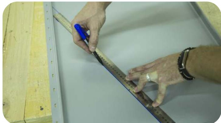
Из деревянных брусков сколотите шаблон. Зафиксируйте на шаблоне угол между линией ендовой и панелью. Используя шаблон, перенесите на панель линию отреза.
