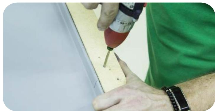
Уложите брусков высотой 30 мм и шириной 50 мм поверх кляммера параллельно панели. Закрепите брусков.
