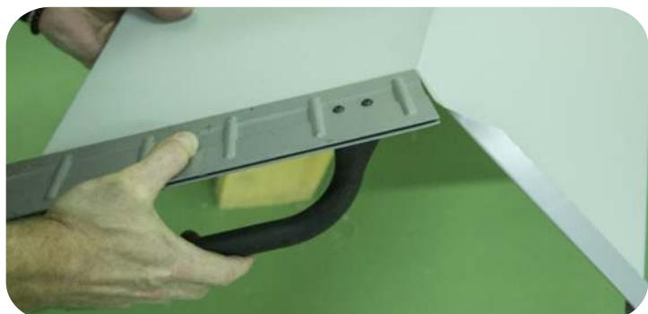
Вдоль линии карнизного свеса на планке ендовы сделайте загиб на 180° длиной 25 мм. Загиб обеспечит плотное прилегание планки ендовы к карнизу без крепления саморезами.
