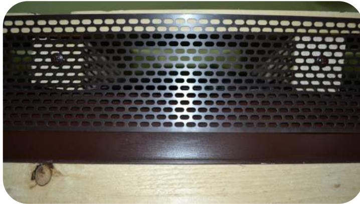
Зазор между капельником и доской начальной обрешетки необходимо закрыть карнизной лентой для защиты подкровельного пространства от насекомых и птиц.
