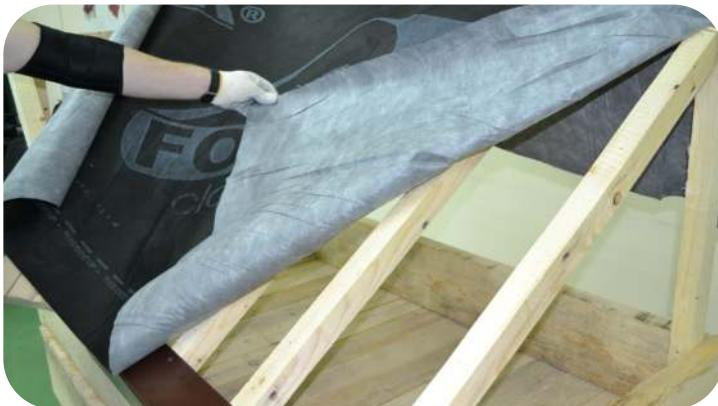
На стропила уложите гидроизоляционный материал, закрепив к стропилам строительным степлером.
