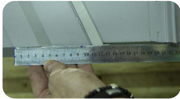
Отметьте линию загиба панели на карнизе на расстоянии 25 мм от края. Замерьте расстояние от замка уже смонтированной панели до края крепежной планки и перенесите на линию загиба.
