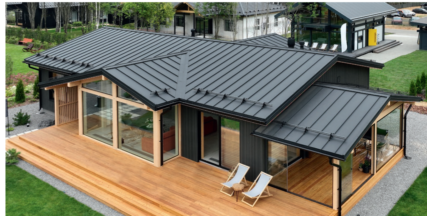
Кликфальц® Pro Satin Matt RAL9005, снегозадержатели для фальцевой кровли Grand Line. Объект Балтийский зодчий
