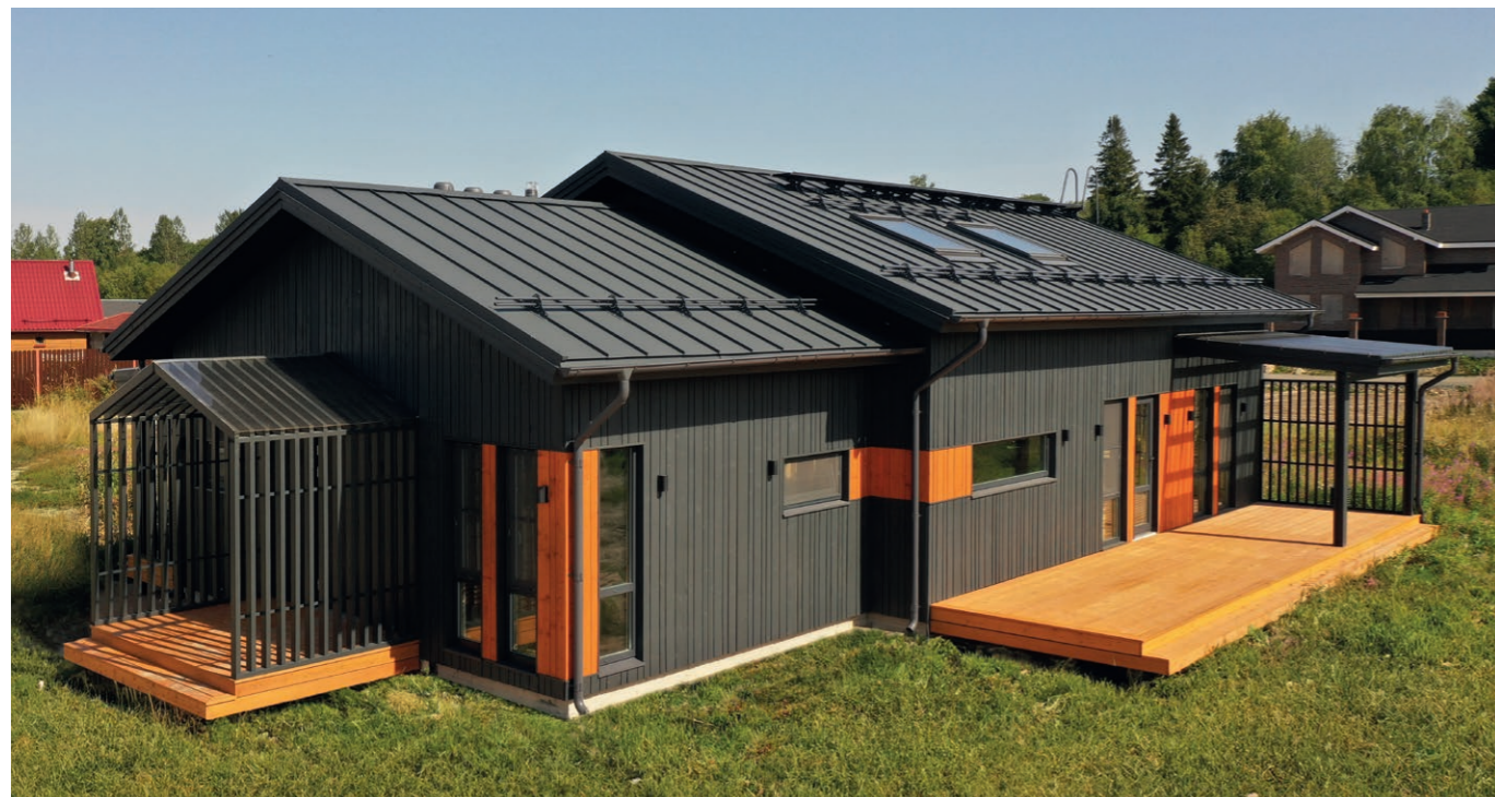
Кликфальц® Satin Matt RAL7016, водосток металлический Grand Line 125/90 мм, снегозадержатели для фальцевой кровли Grand Line. Объект АртСтрой
