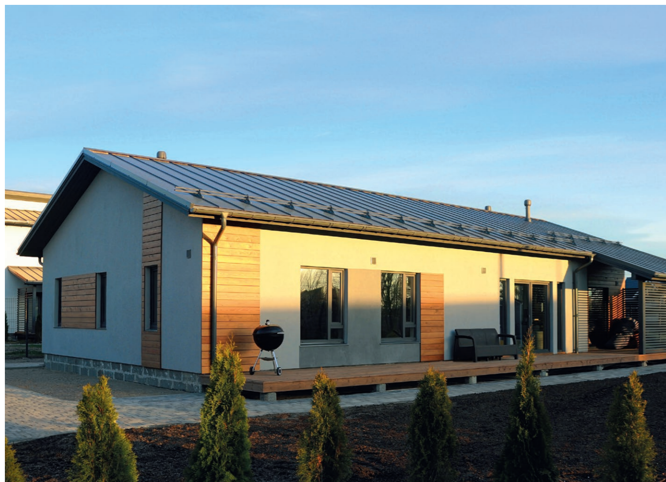
Кликфальц® Satin RAL7024, снегозадержатели для фальцевой кровли Grand Line. Объект Балтийский зодчий
