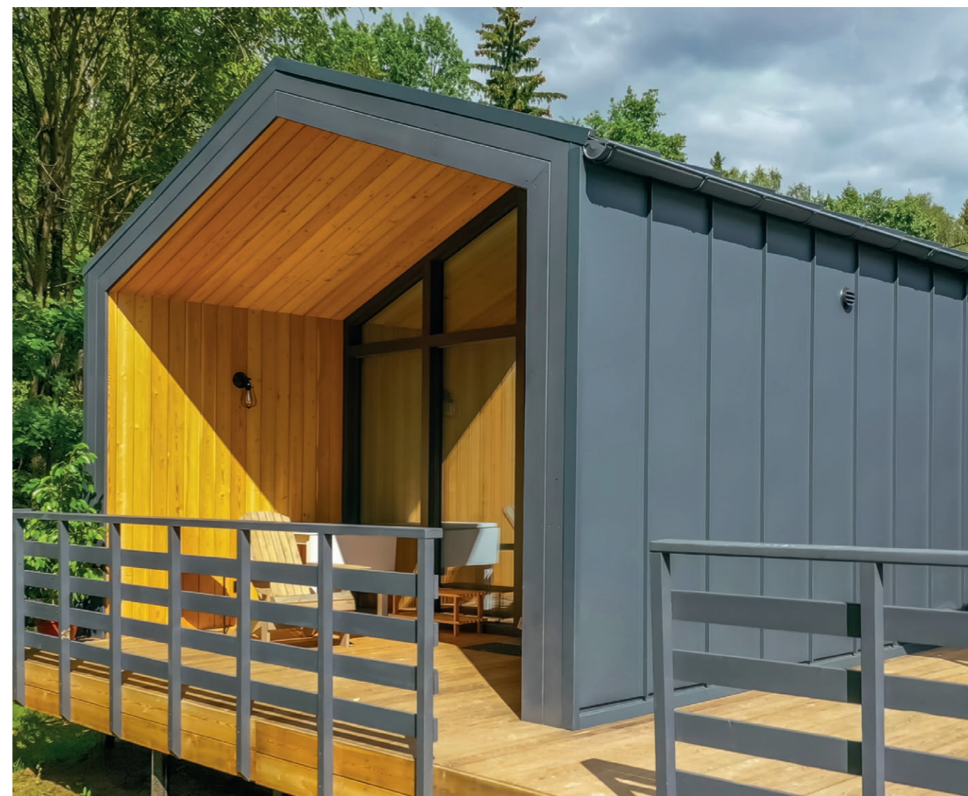
Кликфальц® Pro PurLite Matt RAL7024, водосток металлический Grand Line 125/90 мм. Объект OKprefab
