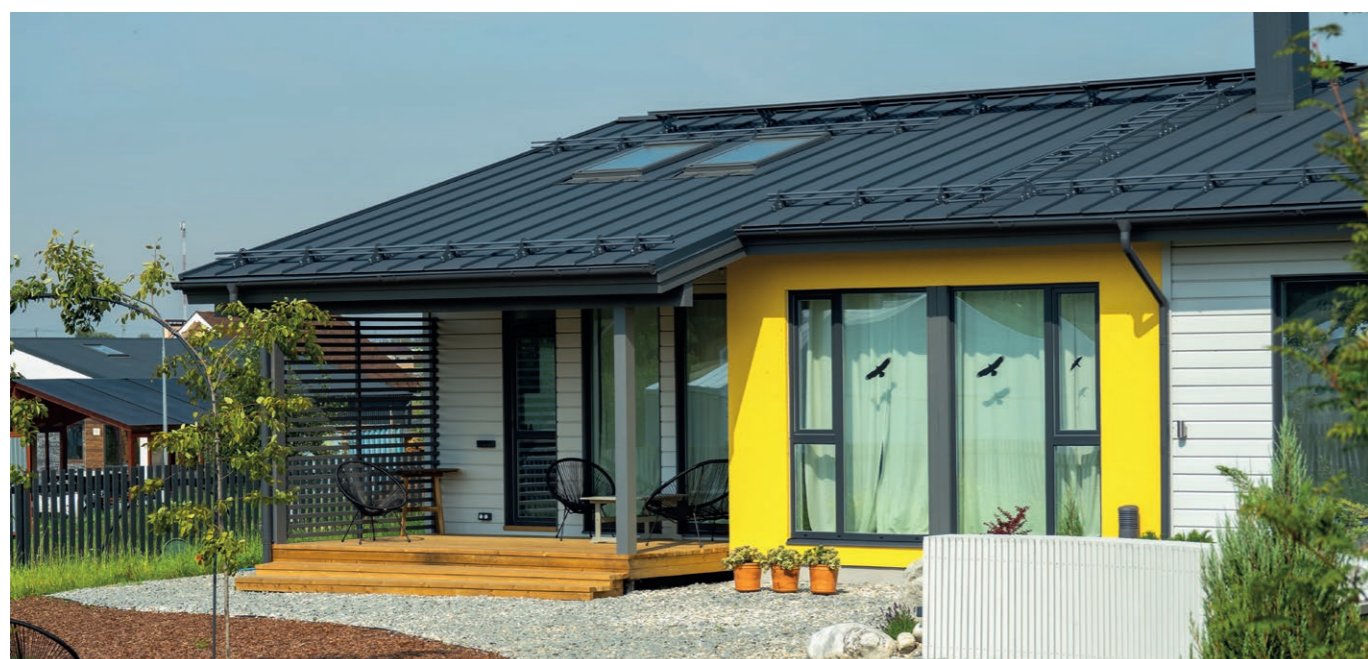
Кликфальц® Pro Satin Matt TX RAL7024, водосток металлический Grand Line 125/90 мм, снегозадержатели для фальцевой кровли Grand Line, переходные мостики Grand Line. Объект Izburg
