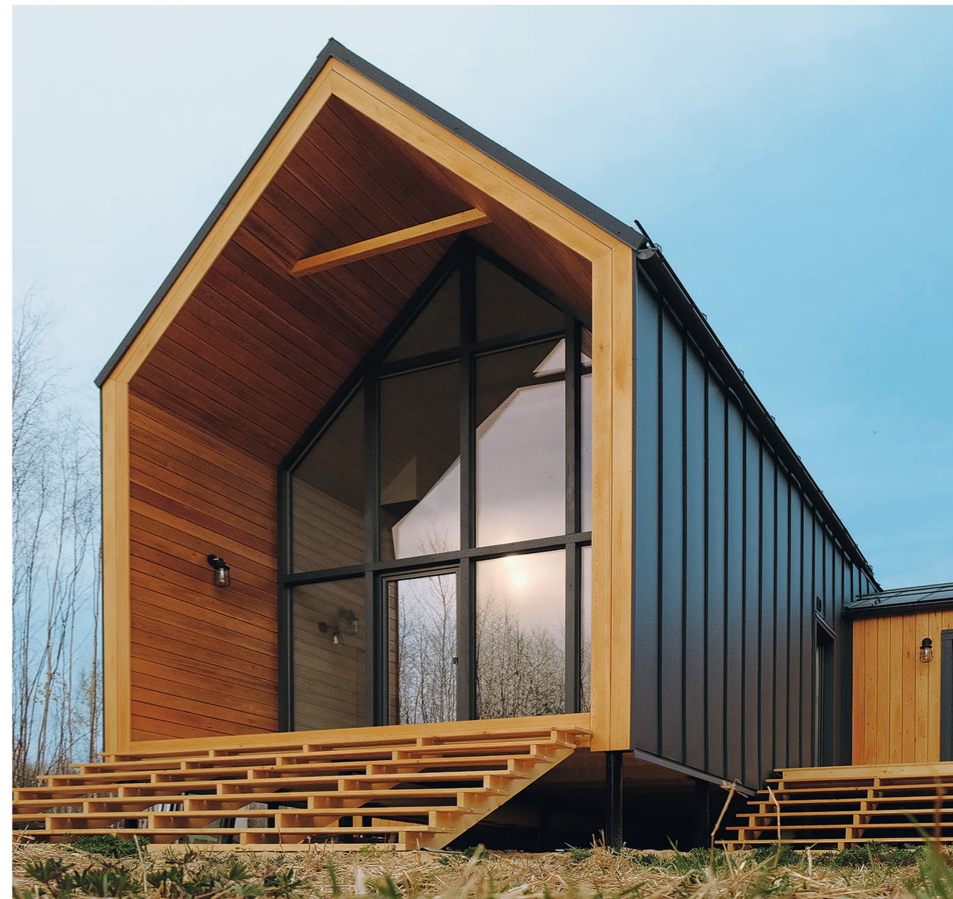
Кликфальц® Rooftop Бархат RAL7024. Объект ОКPrefab
