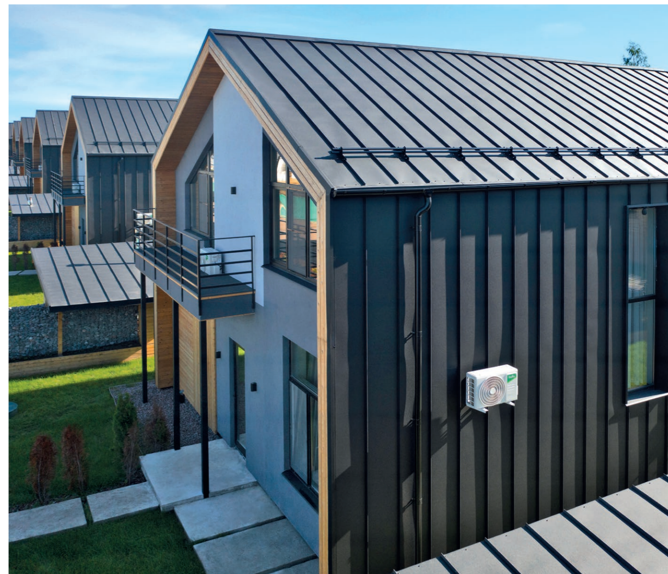
Кликфальц® Fin 24 Drap RAL9005, водосток металлический Grand Line 125/90 мм, снегозадержатели для фальцевой кровли Grand Line. Объект Rempiter
