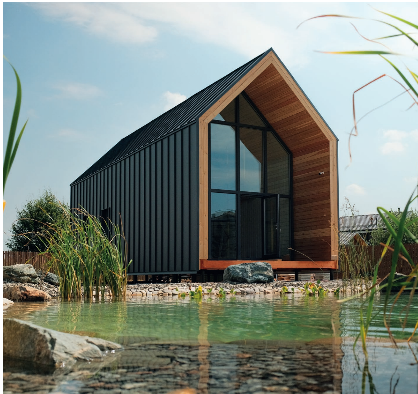
Кликфальц® Pro Rooftop Бархат RAL7024. Объект ОКprefab
