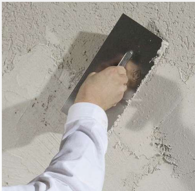
После высыхания слоя (не менее 1 дня) в шахматном порядке, неплотно друг к другу, наносится смесь Baumit CreativTop Silk.*
