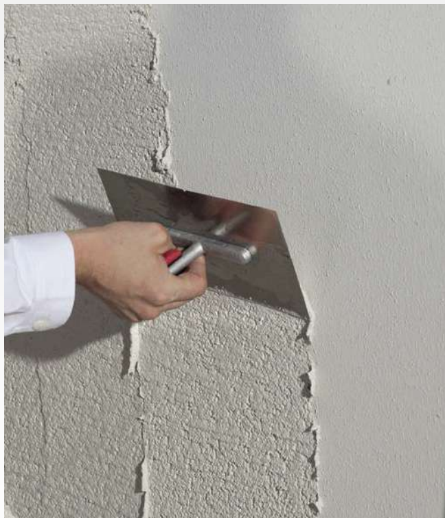
Смесь Baumit CreativTop наносится на всю поверхность...
