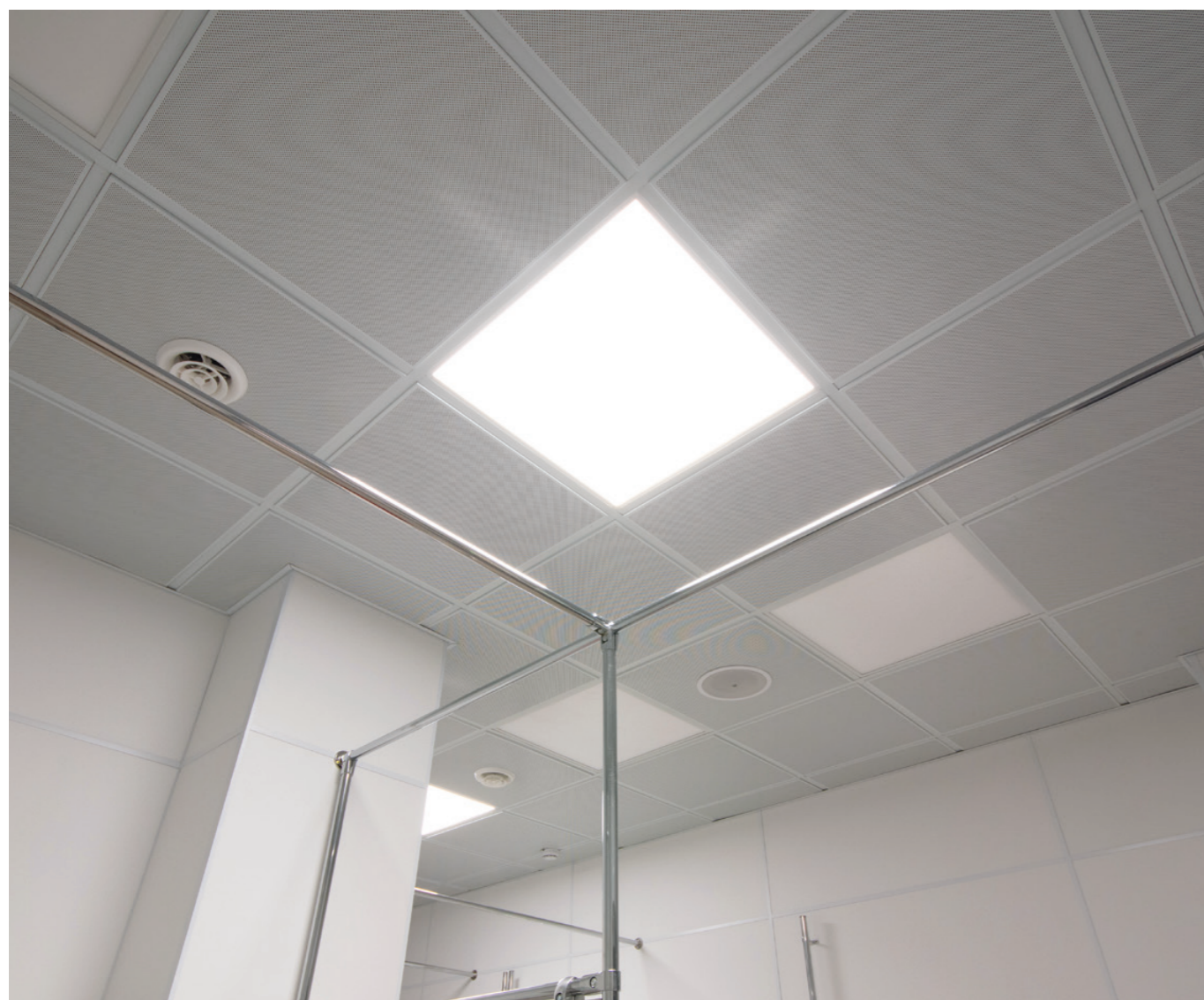
Открытая кассета 600x600 мм с перфорацией Tegular 90°, белый (RAL 9003) Zn 0,5 Подвесная система Премиум Плюс Т-24, белый (RAL 9003)
